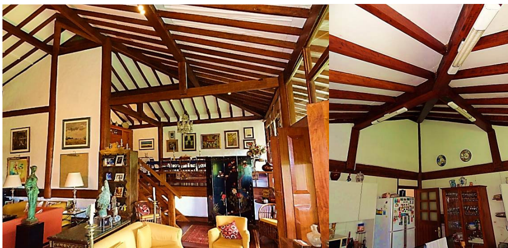
Figura 7. Estrutura principal e vigamento da cobertura.
