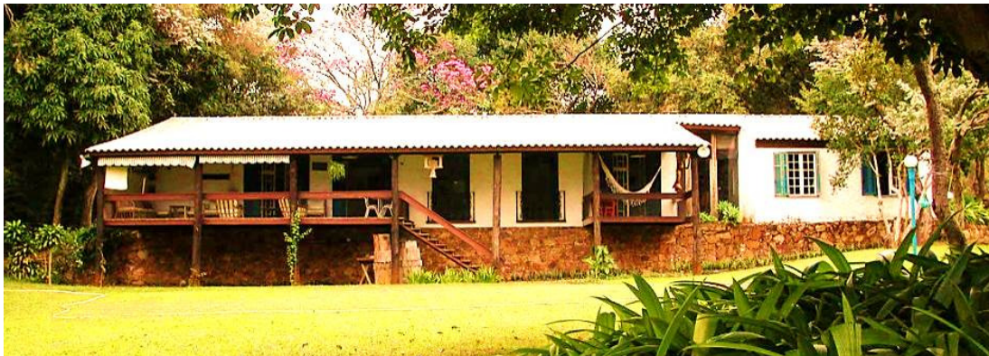
Figura 9. Fachada principal da residência 03
