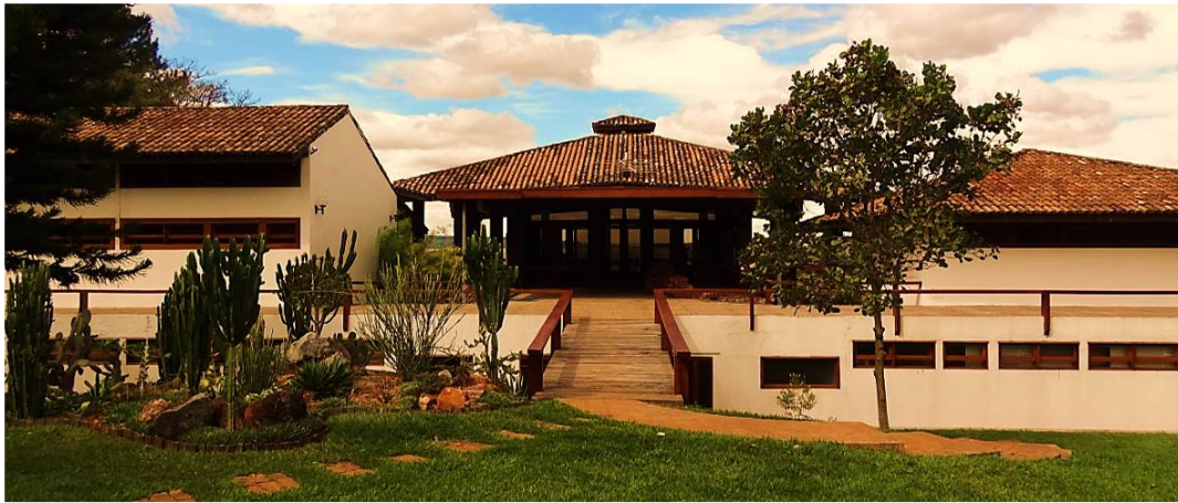
Figura 2. Vista posterior do acesso principal, dos 3 blocos e conexão via passarela
