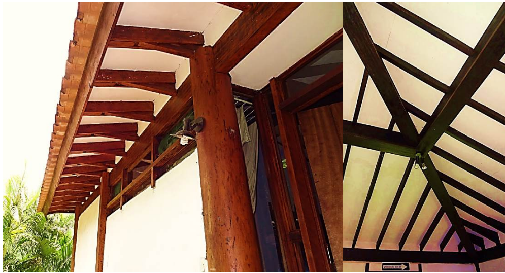
Figura 8. “Cachorros” e estruturas do telhado
