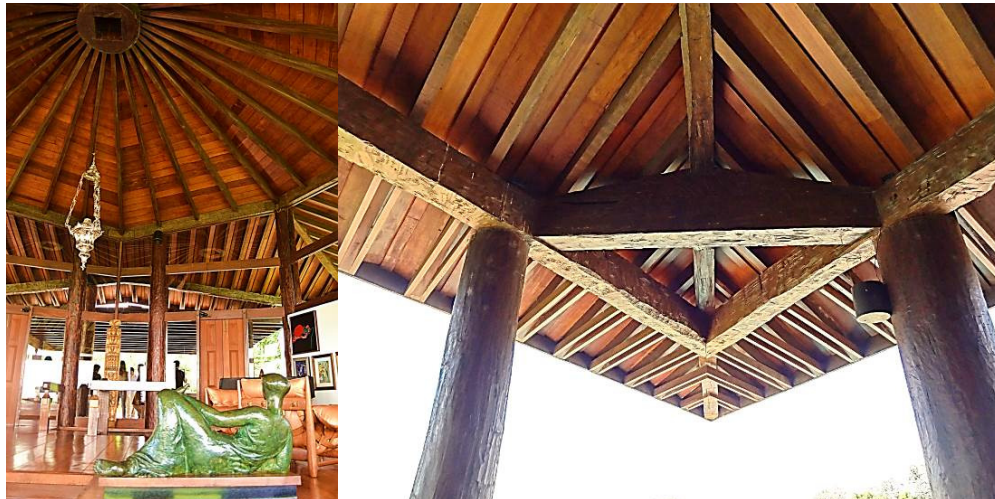
Figura 4. Detalhes dos forros inclinados e das estruturas da coberturas
