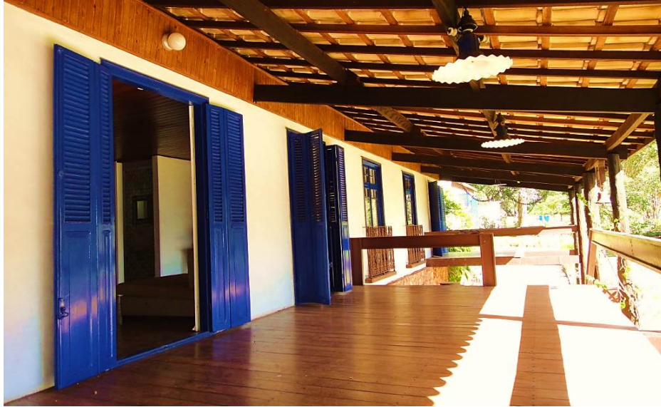
Figura 10. Varanda e esquadrias da residência 03
