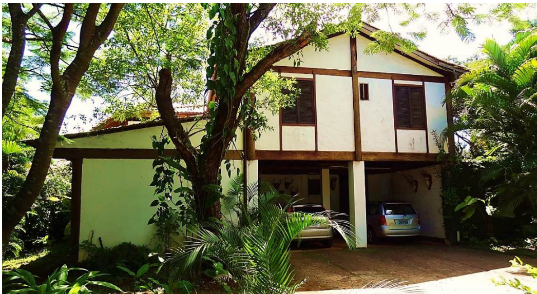
Figura 5. Aspectos da fachada com atenção para os requadros
